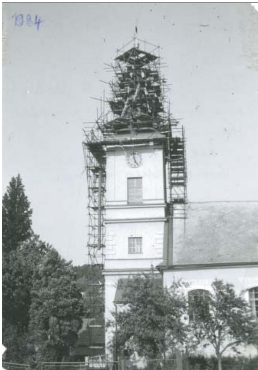
Pokryvání špice kostelní věže měděným plechem v roce 1984
